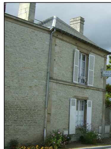
Construction à proximité immédiate du château : toiture à quatre pans en ardoises et murs en pierres de Caen
